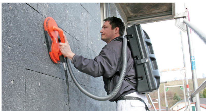
Støvfritt arbeid på stillas
