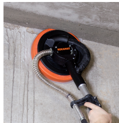
Sliping av betong ujevnheter
