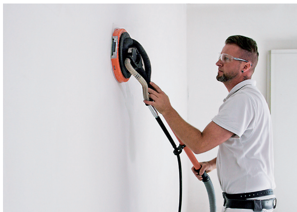
Rask og effektiv sliping av store overflater
