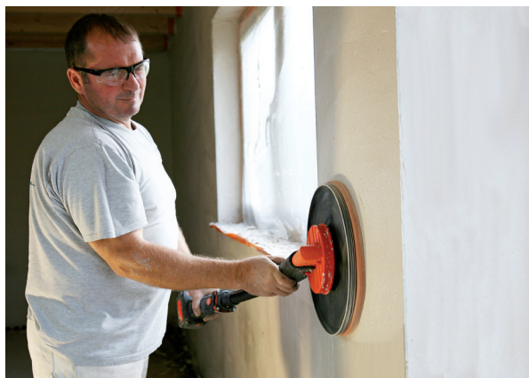
Avslappet arbeidsposisjon på store veggflater
