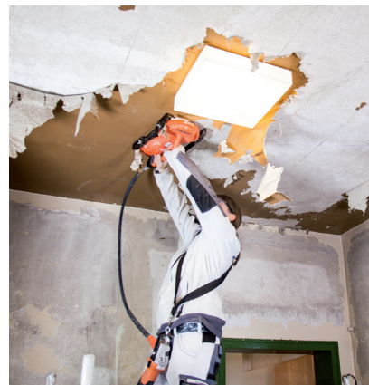
Stripping av tapet
