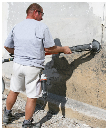
Sliping av bitumenbelegg med PCD-slipekive
